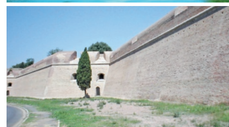
Uso del mattone a mano nel ripristino delle specchiature di Ponte Sisto e nel recupero e nel restauro del bastione ardeatino delle Mura Aureliane a Roma.
